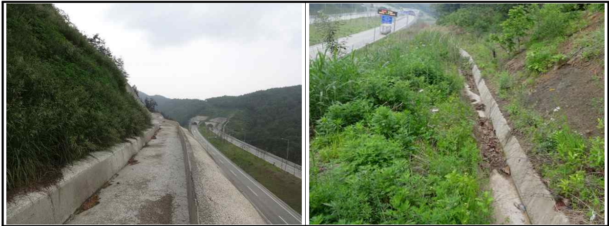
【그림 26.3.3】 배수시설 전경
